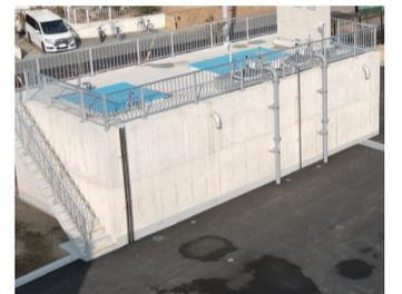
西平井浄水場の新しい水処理施設(塩素接触池、着水井)
