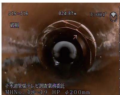
劣化して破損した下水道管
