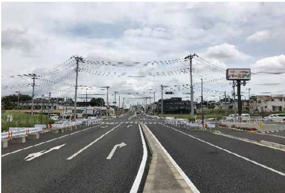
西平井・鰐ヶ崎地区（新川南流山線）
