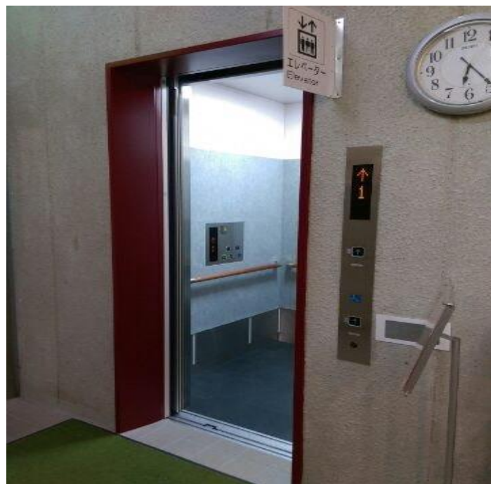
更新後の文化会館エレベーター
