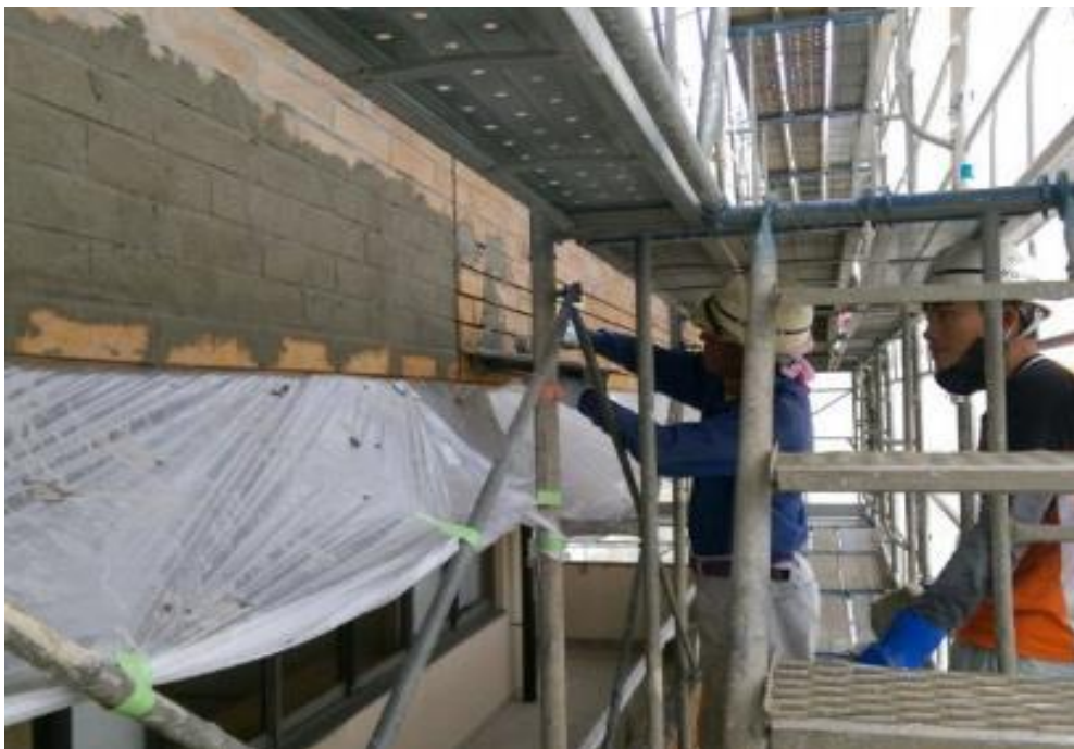
南流山センター外壁改修工事
