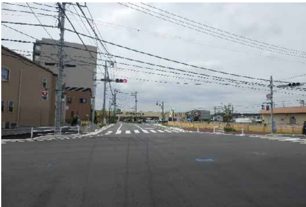
三輪野山西平井線工事完成後
