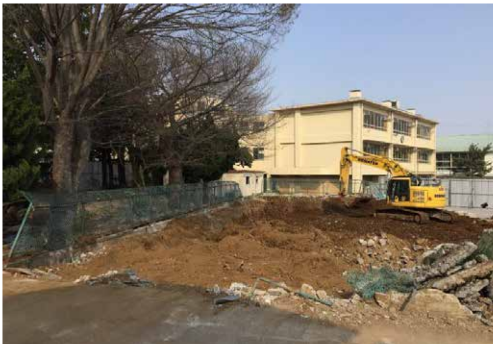
既存プールの解体
