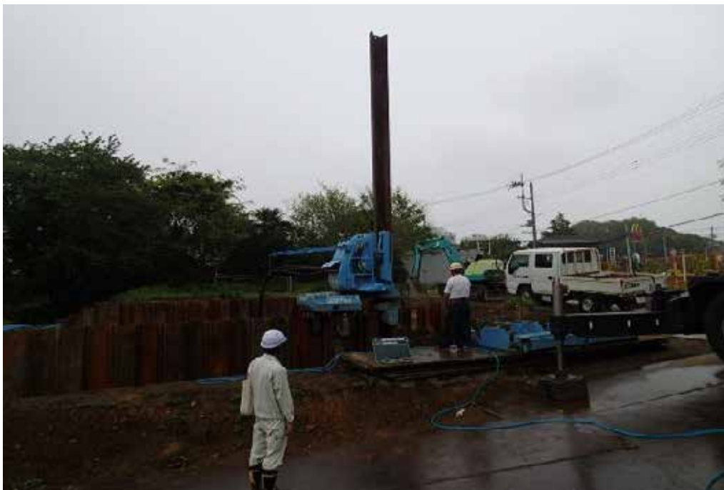
和田堀都市下水路新樋管築造工事施工状況
