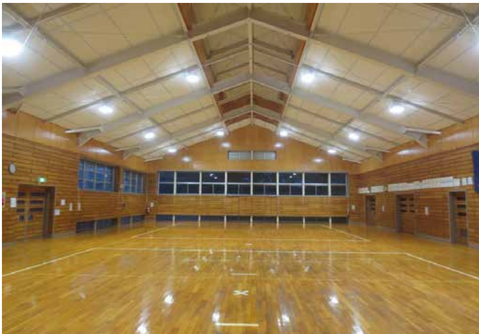
東部中学校武道場吊天井改修工事
