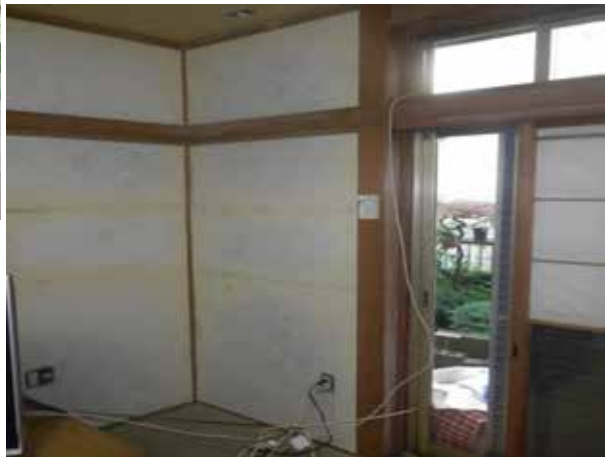
耐震改修工事の施工状況
