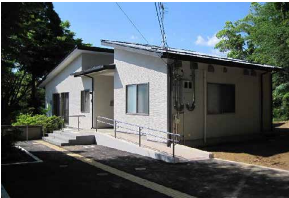
建て替えられた第2コミュニティホーム
