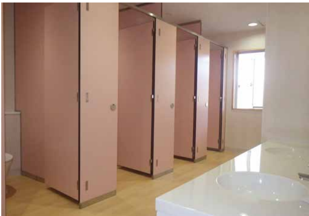
八木南小学校屋内運動場トイレ改造工事
