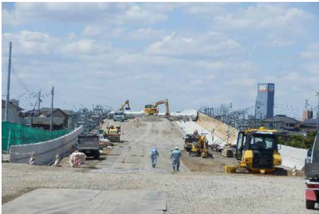
流鉄跨線部工事状況
