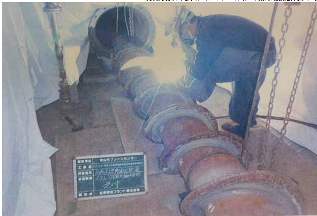
不燃物搬出装置スクリュウ肉盛補修
