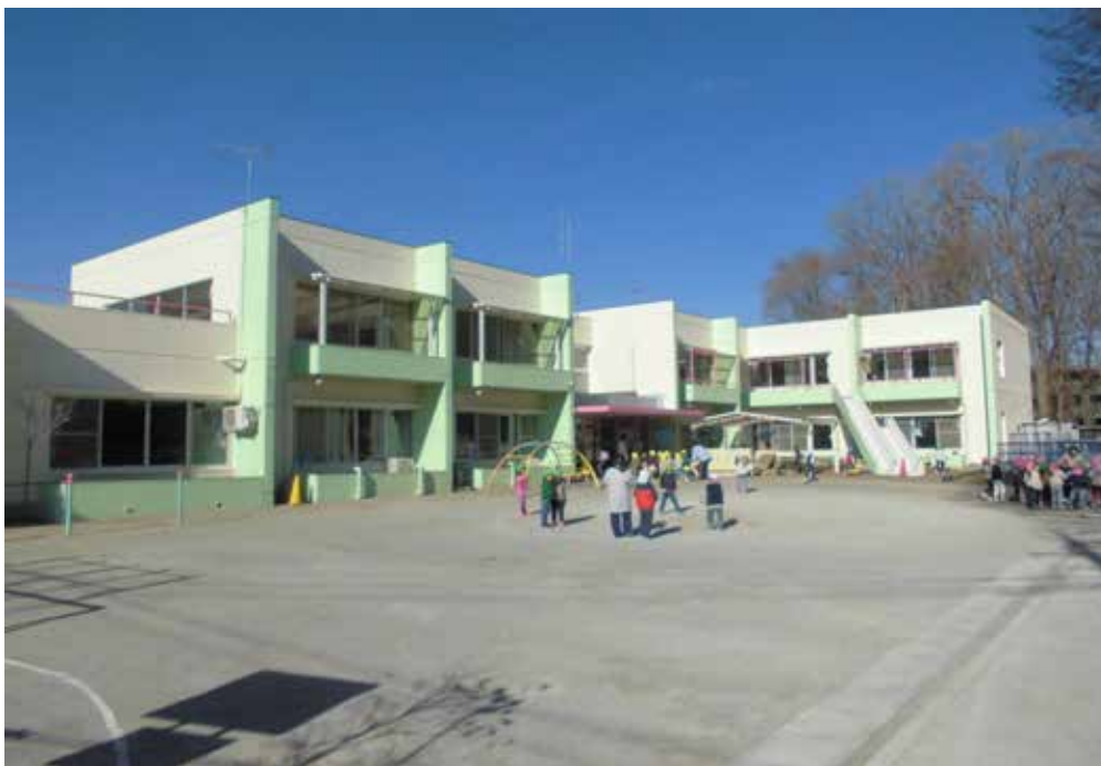
外壁の改修工事を行った東深井保育所
