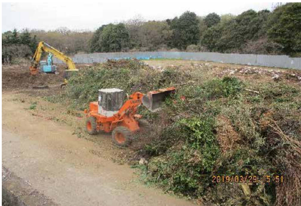
剪定枝等処分業務作業状況
