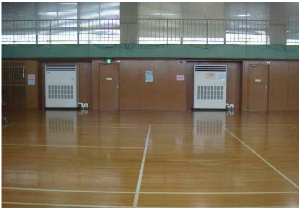
南流山空調設備改修工事
