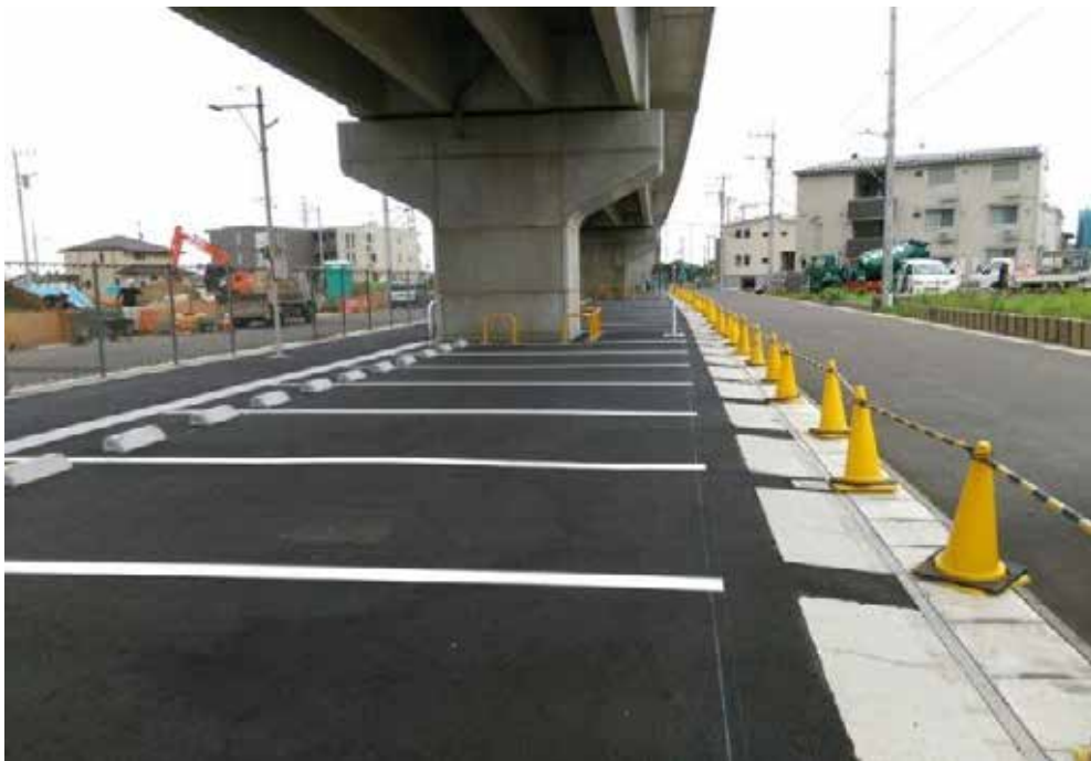
おおたかの森センター駐車場整備工事
