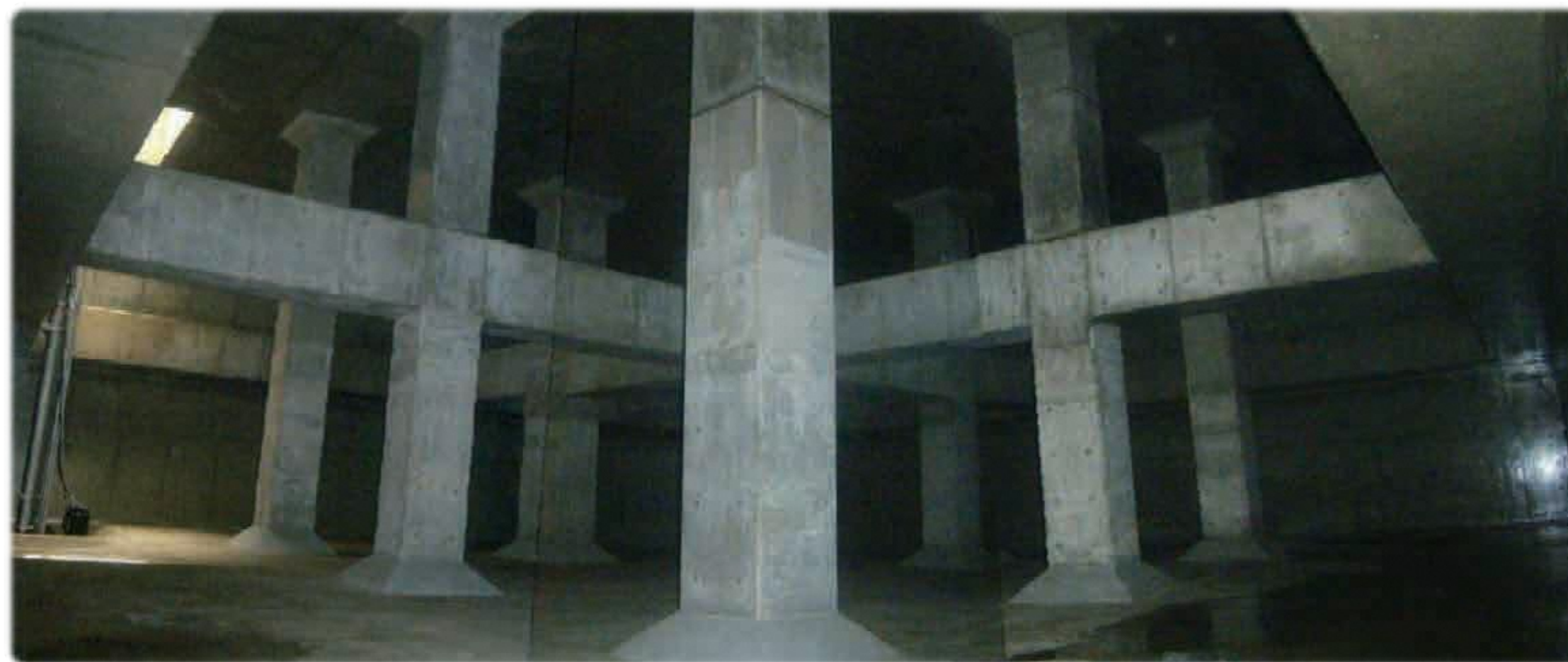
地下に隠された貯留槽
