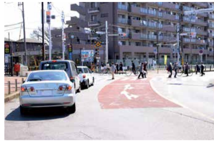
昨年度に道路を補修した平和台駅付近
