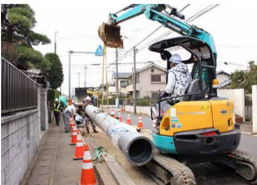
耐震管敷設工事の様子
