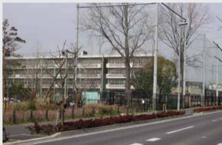
南流山地区児童センター・地域図書館の建設予定地
