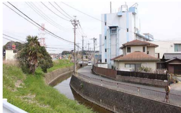
和田堀都市下水路改修箇所
