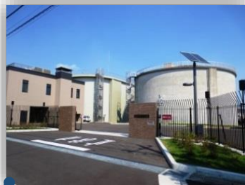
えどがわだいじょうすいじょう 江戸川台浄水場
