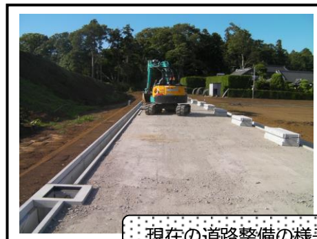
現在の道路整備の様子
