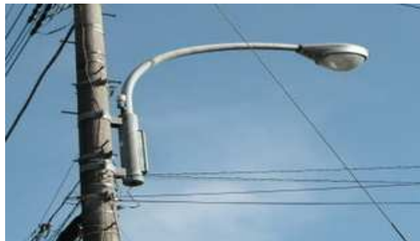
道路照明灯（設置例）
