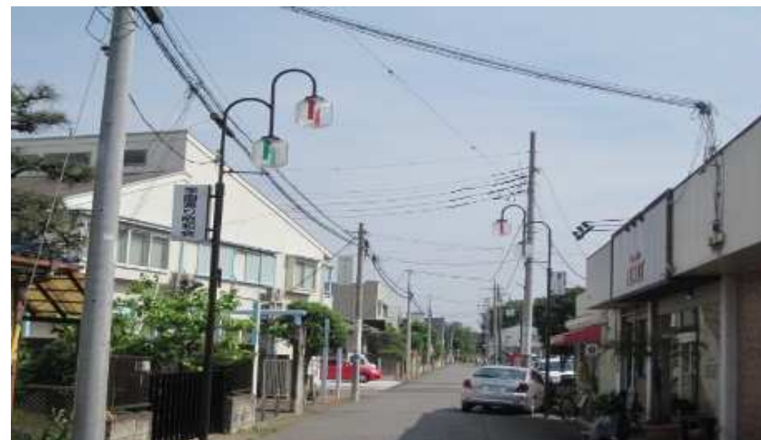
商店街街路灯（設置例）
