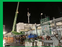
鉄骨組立(線路上空)
