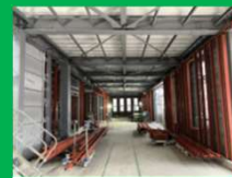
内装工事(自由通路)
