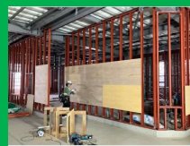
内装工事(橋上駅舎)
