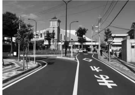
運河駅東口駅前広場
