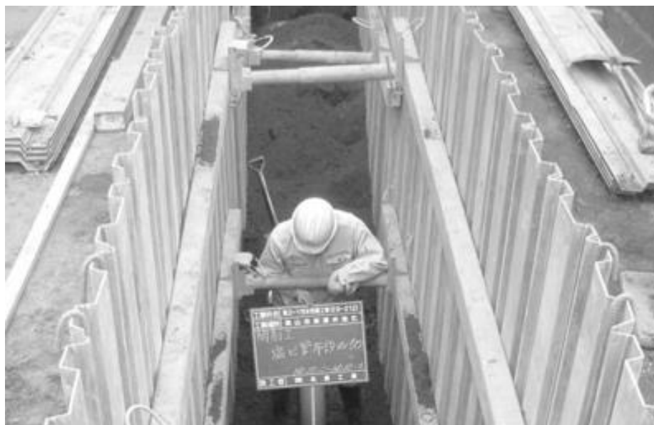
整備が進む公共下水道
