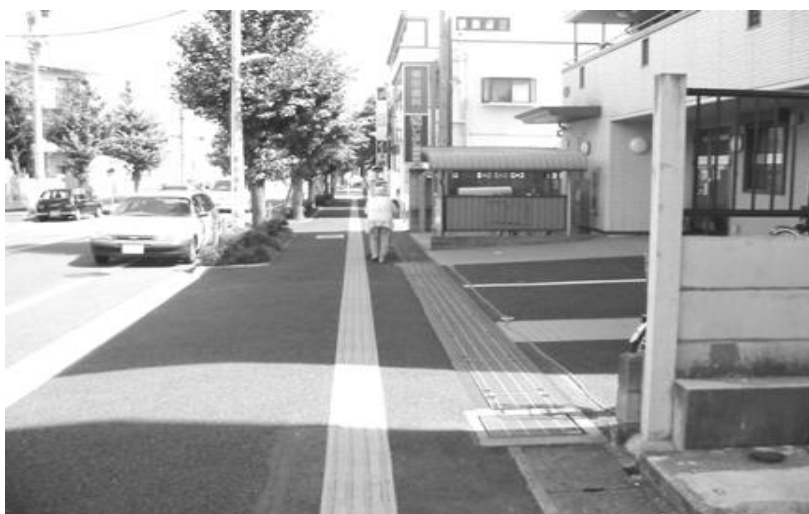
歩道に設置された点字ブロック
