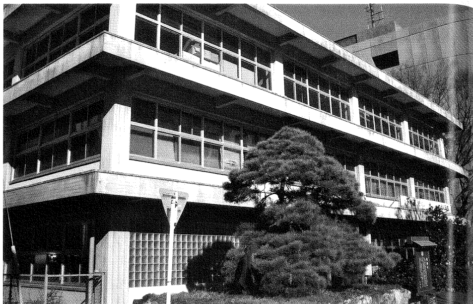
廃止された浜松市の庁舎
