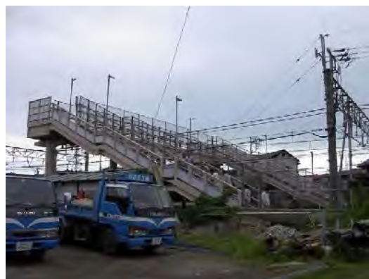
向小金3丁目の歩行者跨線橋
