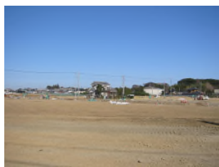
造成工事が進む西平井
