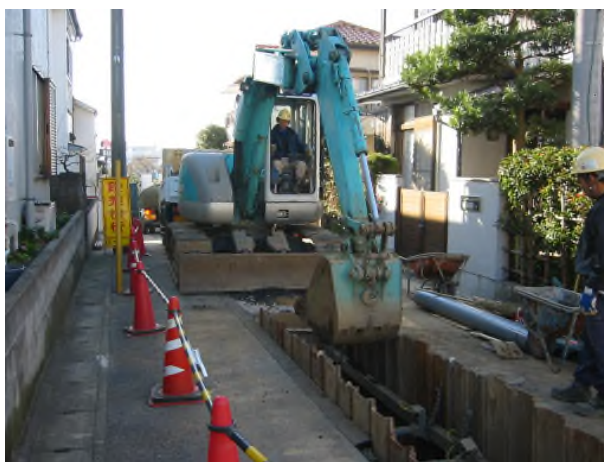
順次整備を進めている公共下水道（前ヶ崎）
