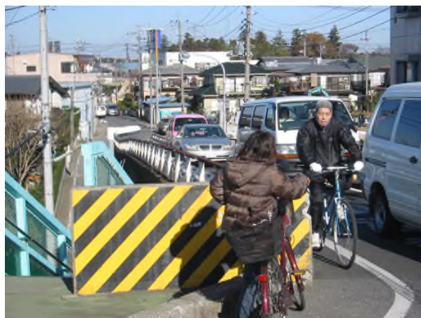
常磐線の跨線橋(向小金)
