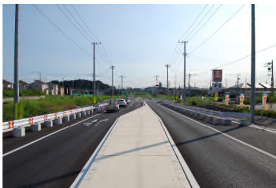
都市計画道路3・3・2号線（西平井）
