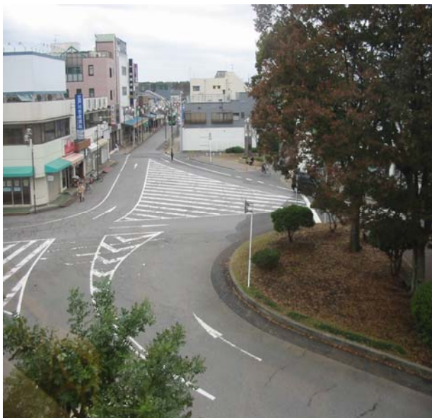
工事前(江戸川台西2丁目地先)
