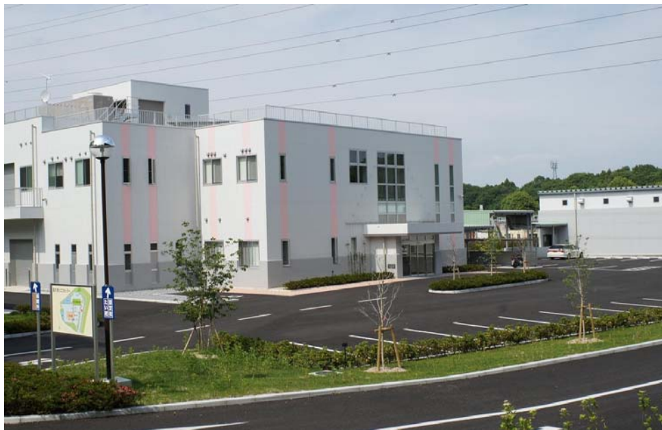
森のまちエコセンター(汚泥再生処理センター)
