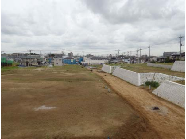
整備中の状況
