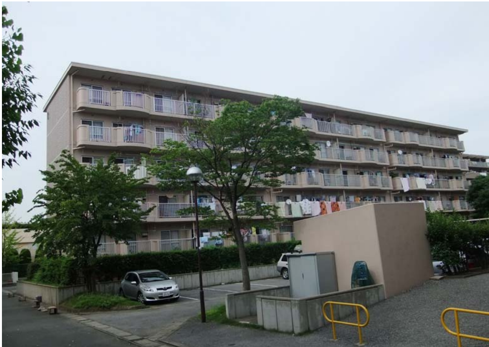
市営住宅柳田団地
