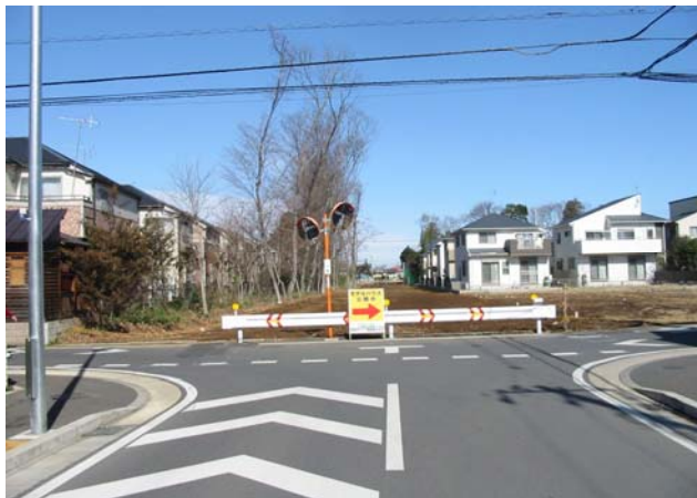
整備中箇所(西初石1丁目地先)
