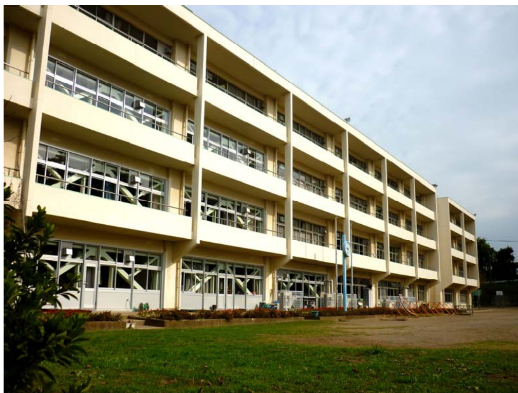
耐震改修後の八木南小学校校舎
