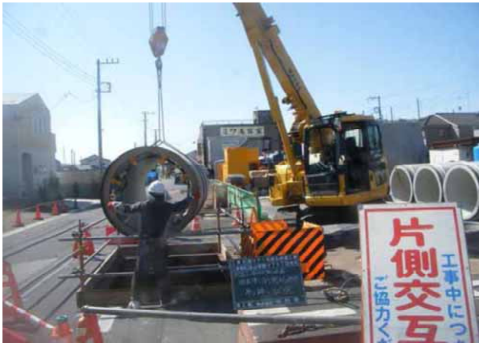
Φ 1, 200mm推進管吊下し状況
