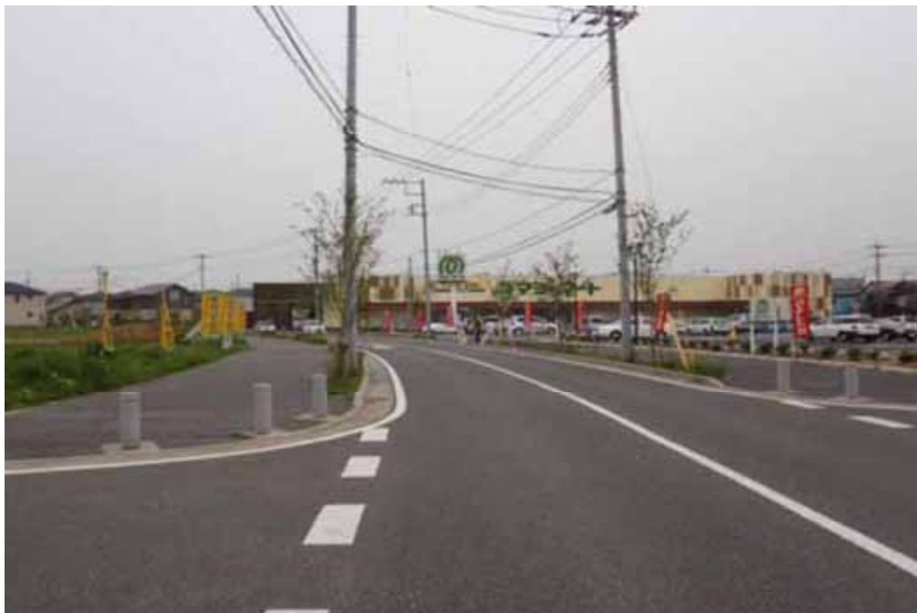
平成24年4月11日に開通した地区内幹線道路 （流山都市計画道路3・5・16号線）
