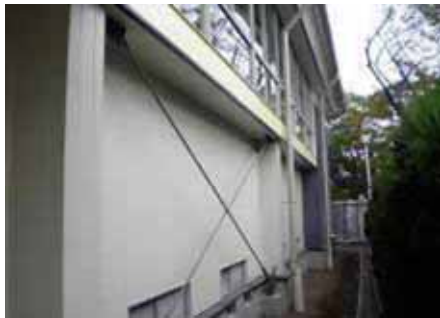
長崎小学校耐震補強
