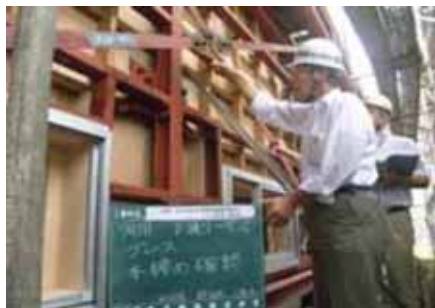
流山北小学校耐震補強
