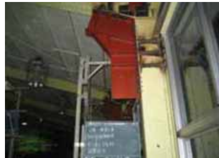
八木北小学校耐震補強
