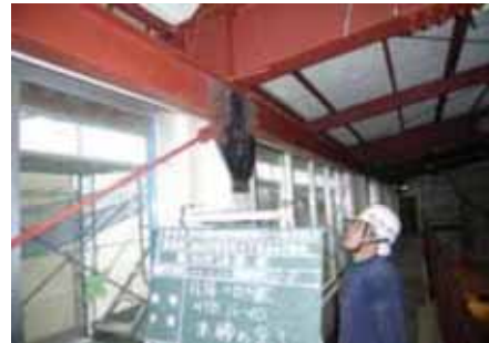
西初石小学校耐震補強
