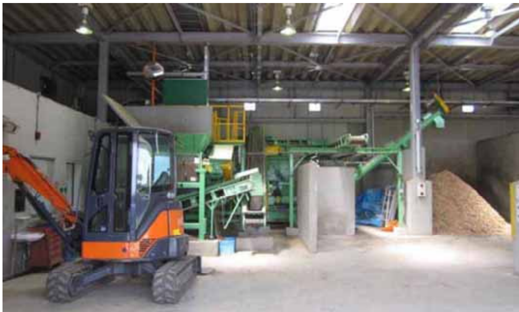
森のまちエコセンター剪定枝資源化棟内部の様子
