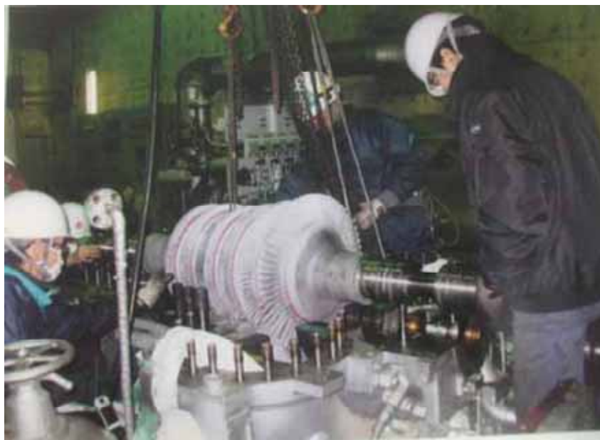
焼却棟タービンローターの組込作業の様子
