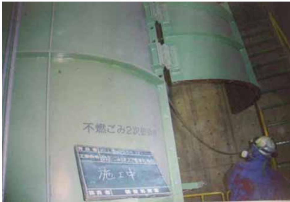
リサイクル館不燃ごみ2次破砕機点検の様子
