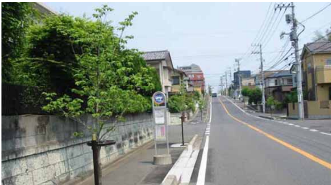
緑化工事が完了した市道221号道路
