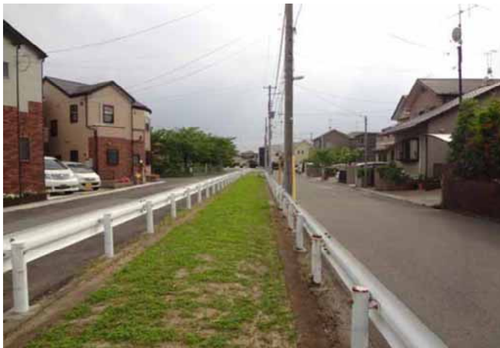
用水路埋立て完成
