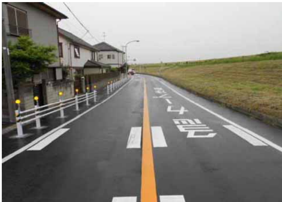
流山7丁目地先道路補修工事完成写真
