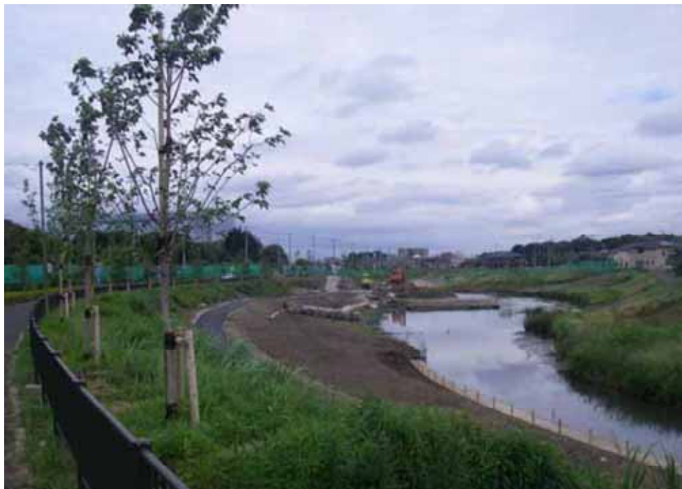
調節池法面植生状況
