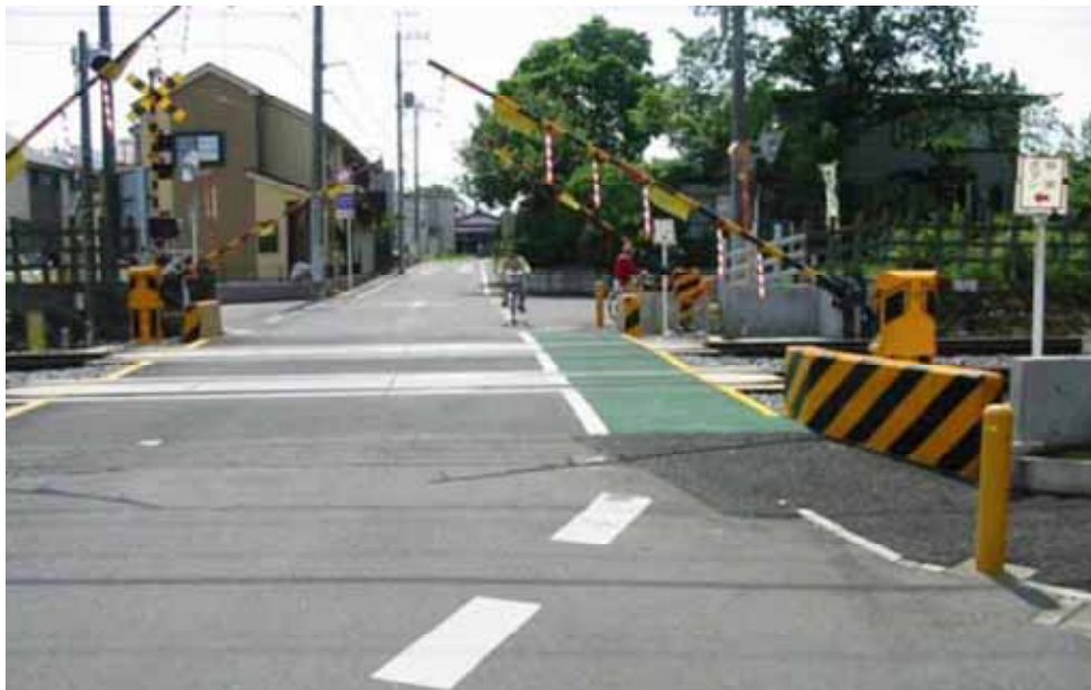
工事完成後の東武野田線201号踏切
