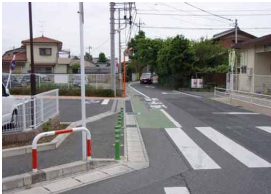
市道前ヶ崎・向小金1号道路
