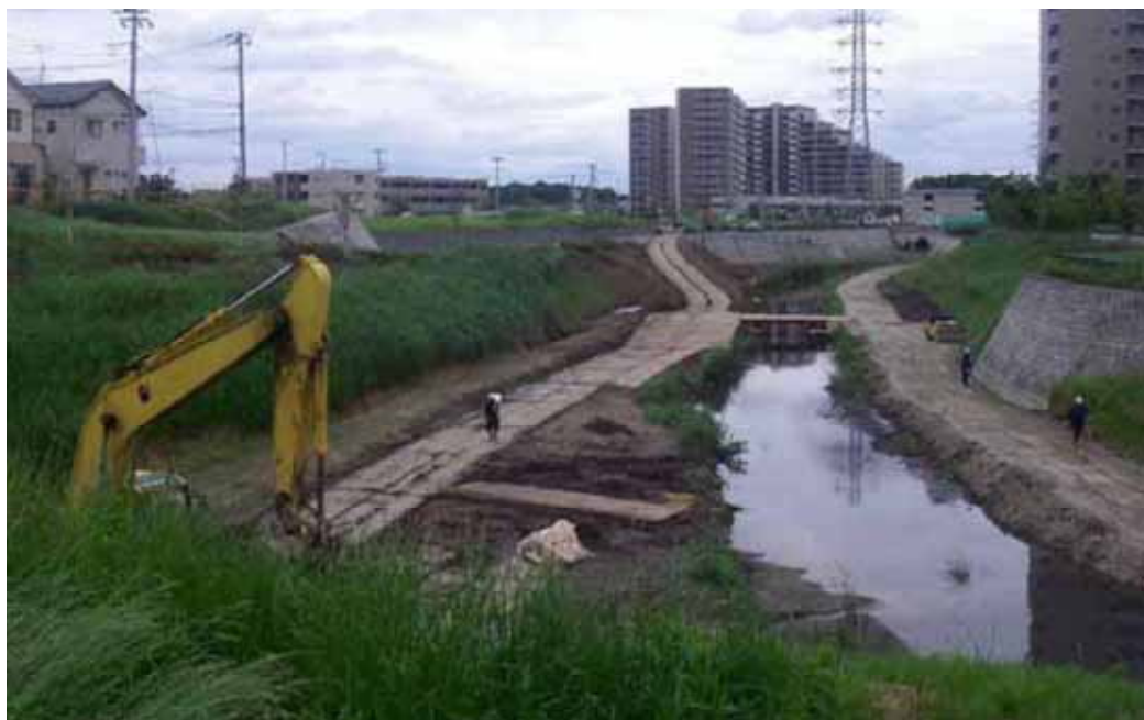
導水管施設状況
