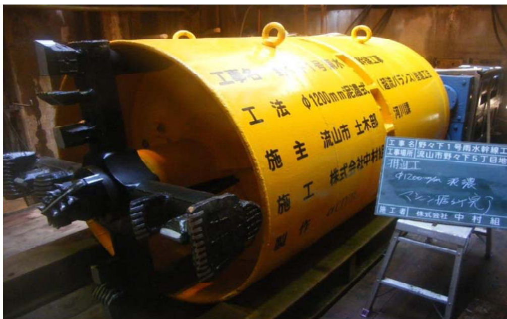
野々下1号雨水管線工事の様子
