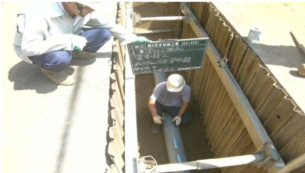
下水道管布設工事の様子
