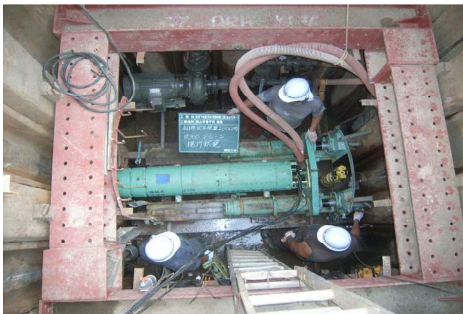
小口径泥水推進工
