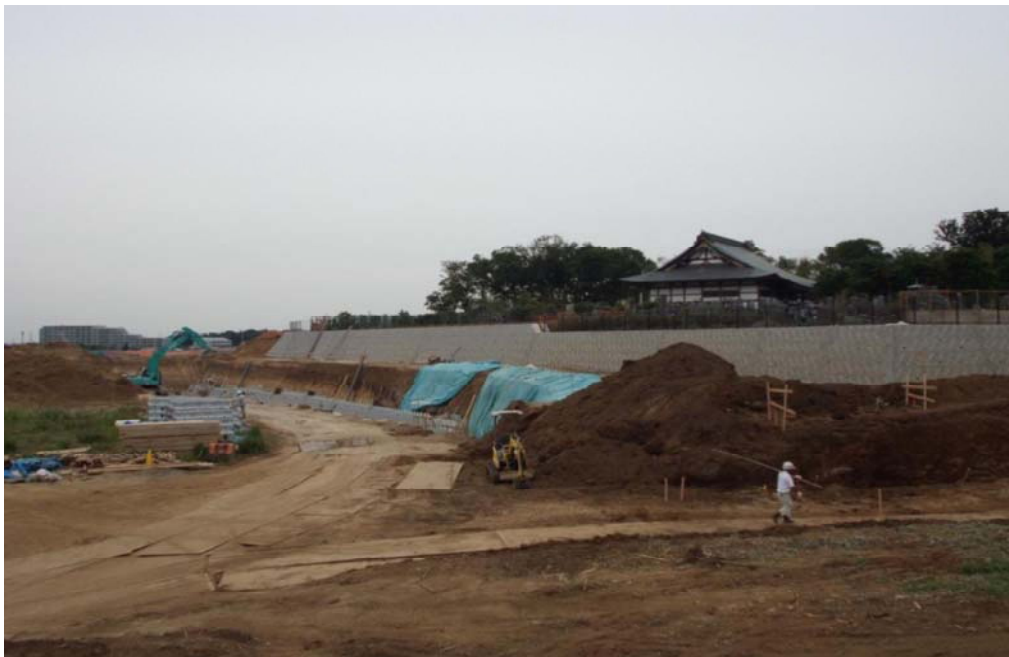
本覚寺南側の工事風景
