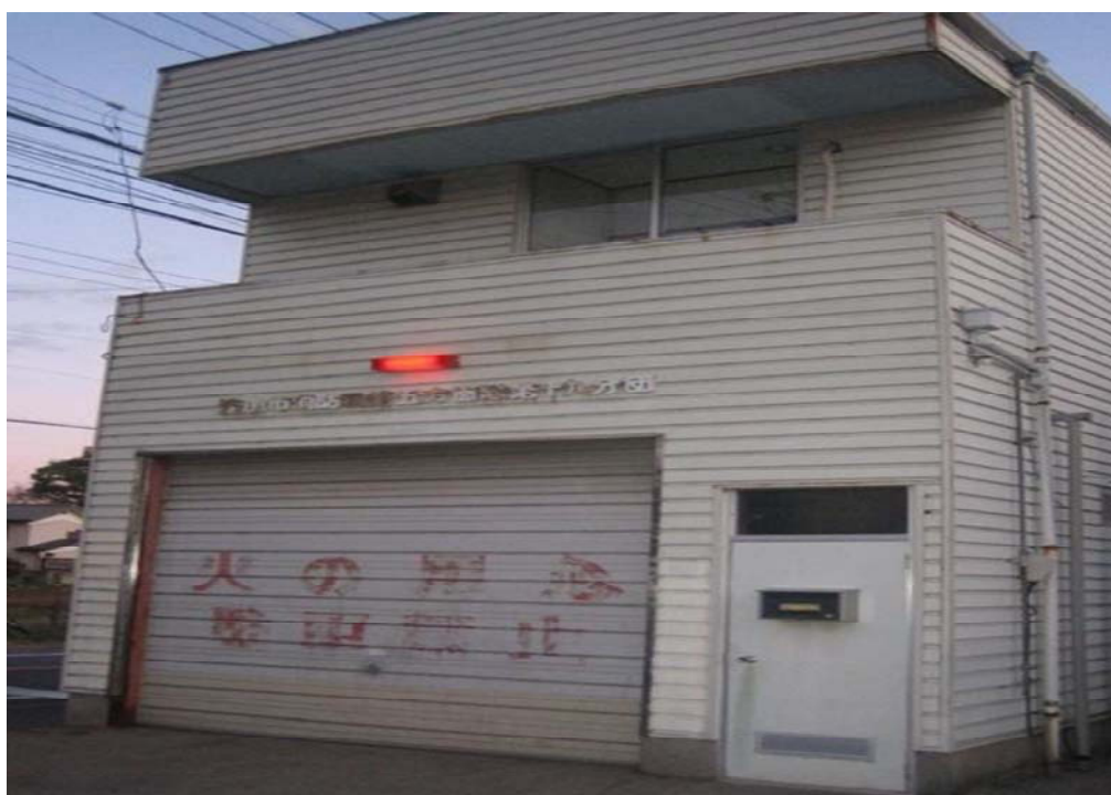
消防団機械器具置場の様子
