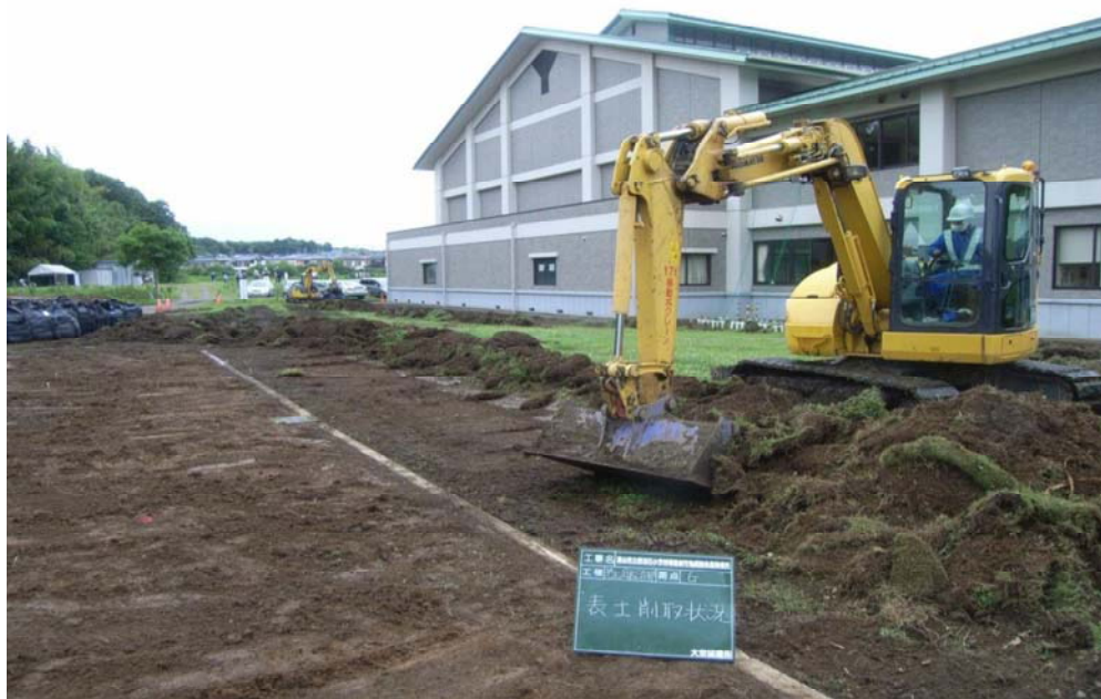
コミュニティプラザの除染作業
