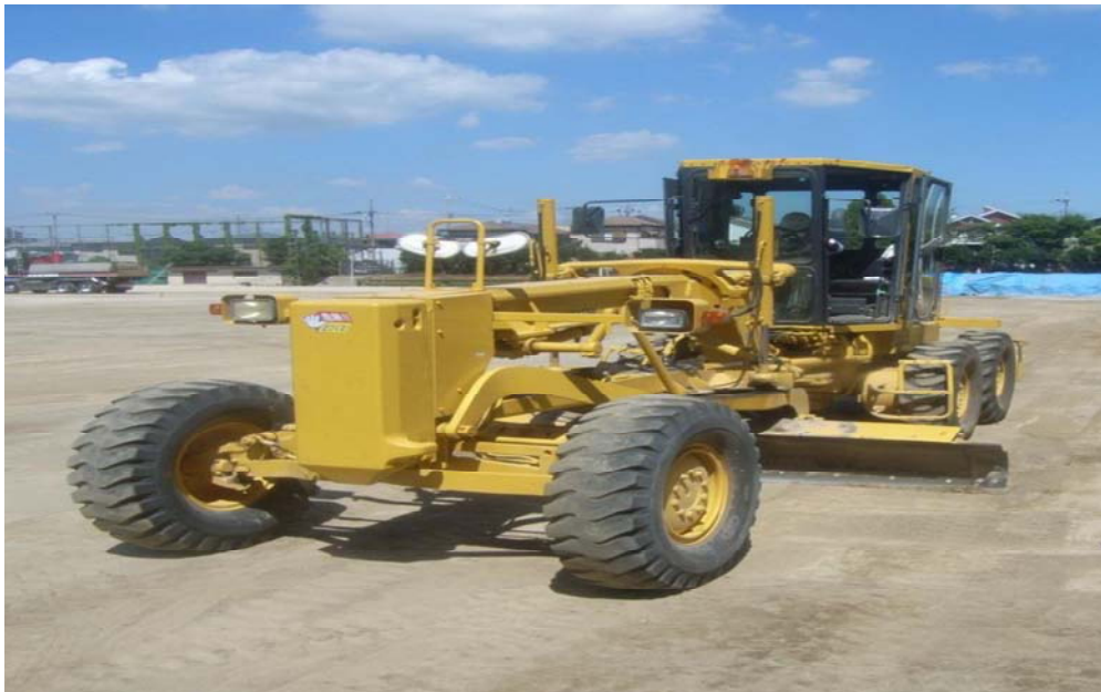
汚染した表土を除去するのに使用した重機
