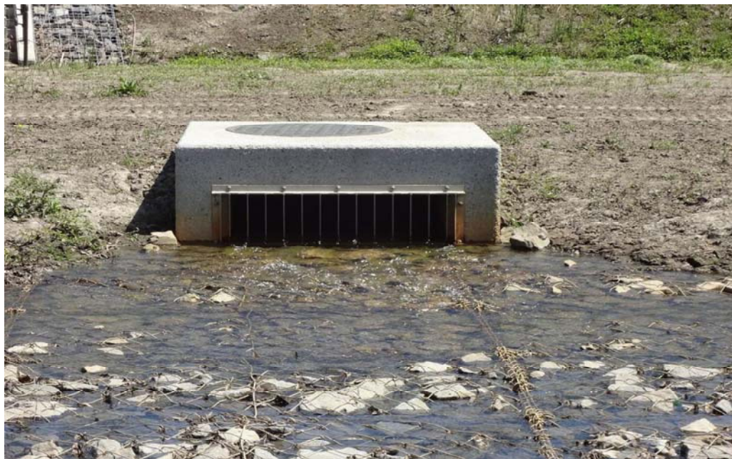
大堀川防災調節池管渠の様子
