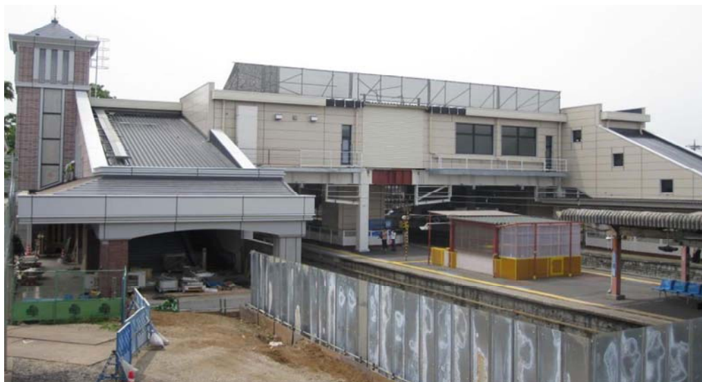
運河駅工事中的様子
