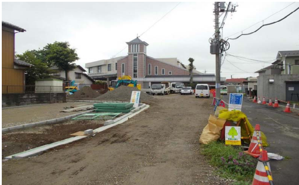
運河駅東口工事の様子
