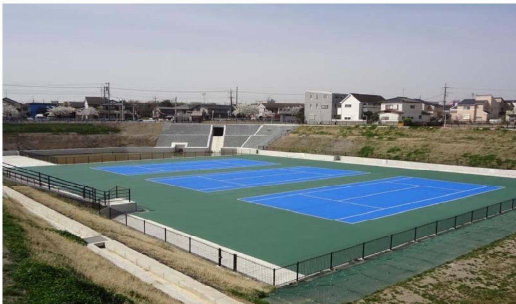
新東谷調整池の様子
