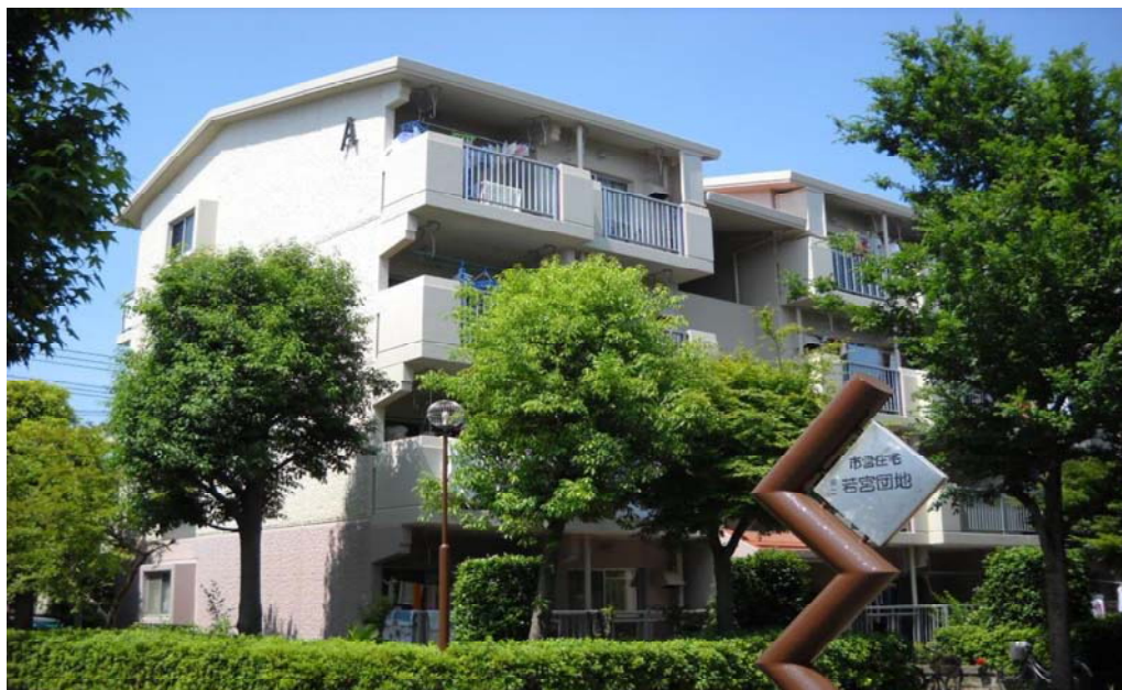
市営住宅若宮団地
