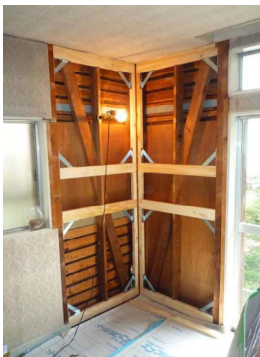
木造住宅の耐震改修
