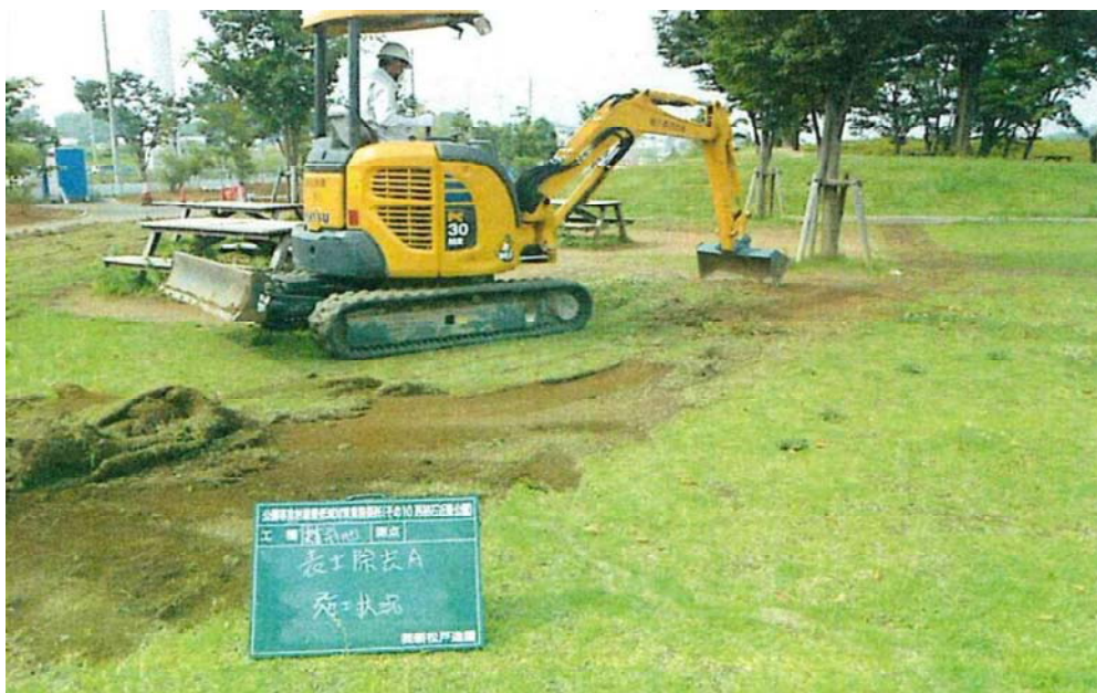
公園の除染作業
