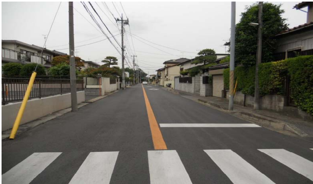
補修後の道路(江戸川台東付近)
