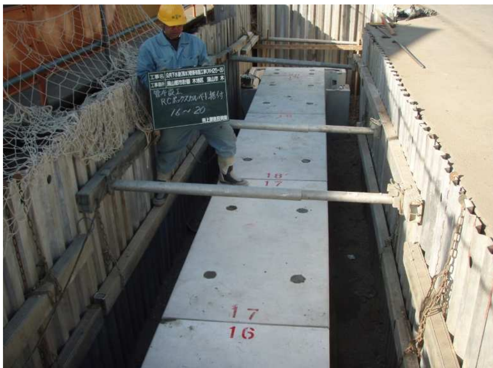
駒木地先下水道管布設工事の様子
