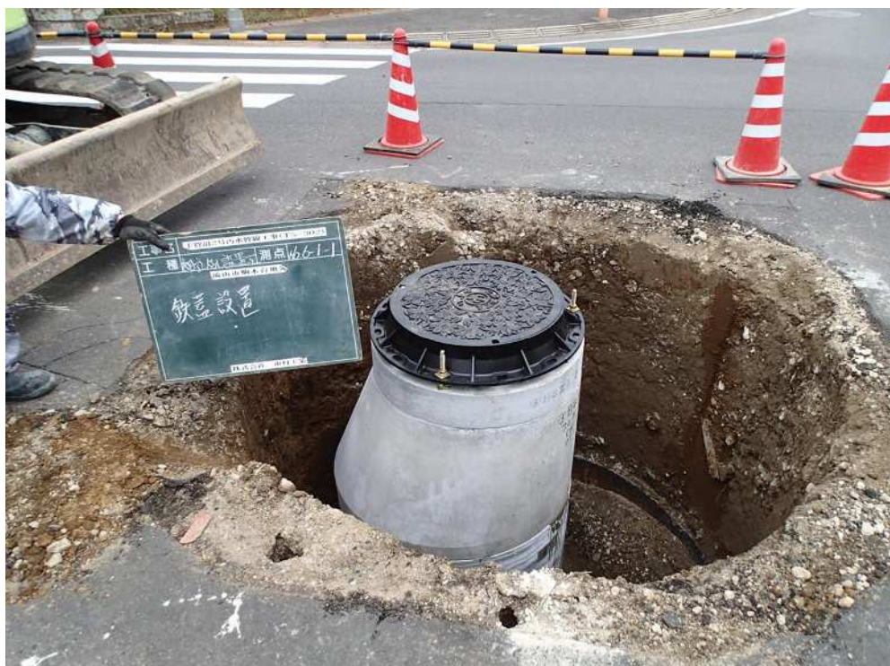
駒木台地先の人孔設置状況
