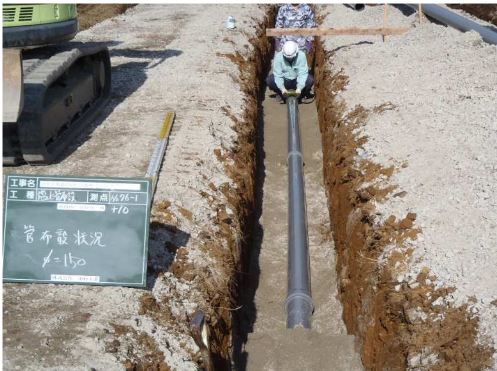
区画整理地区の開削工法による污水管布設状況
