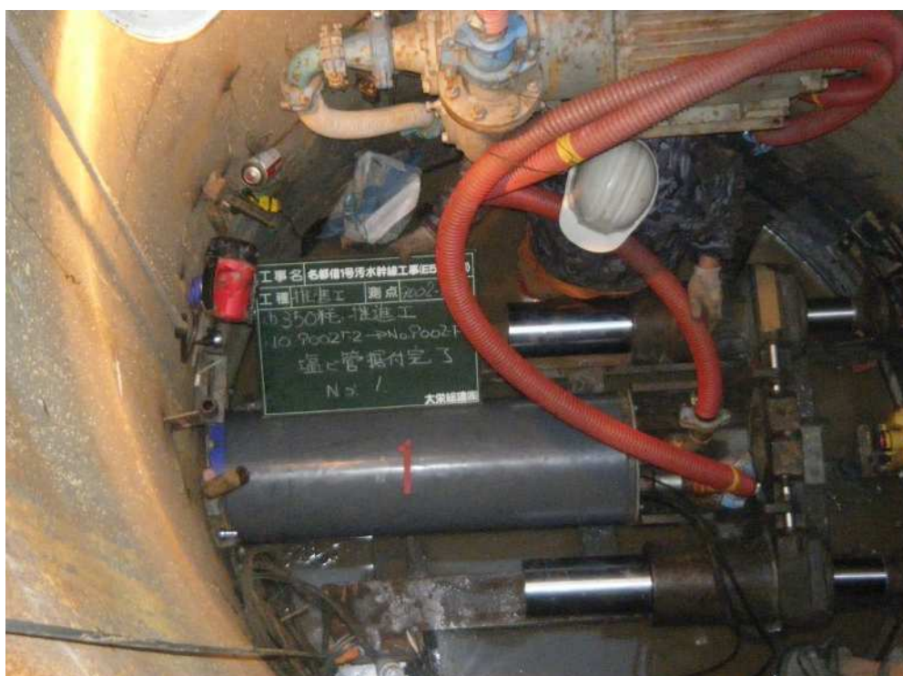
東深井地先の推進工法による汚水管布設状況
