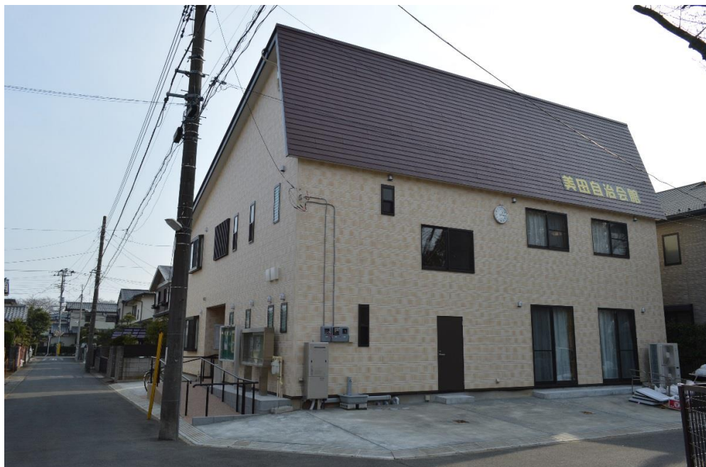
建て替えられた美田自治会館
