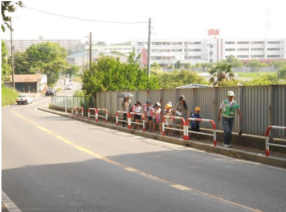
八木南小学校通学路に設置したガードパイプ
