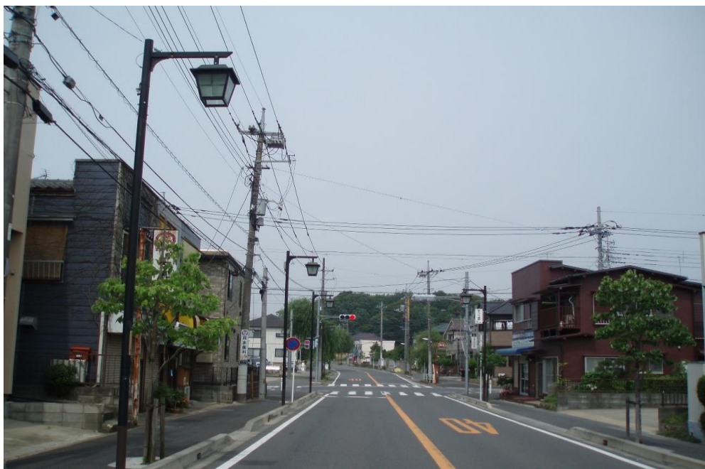
平和台商店会に設置された街路灯
