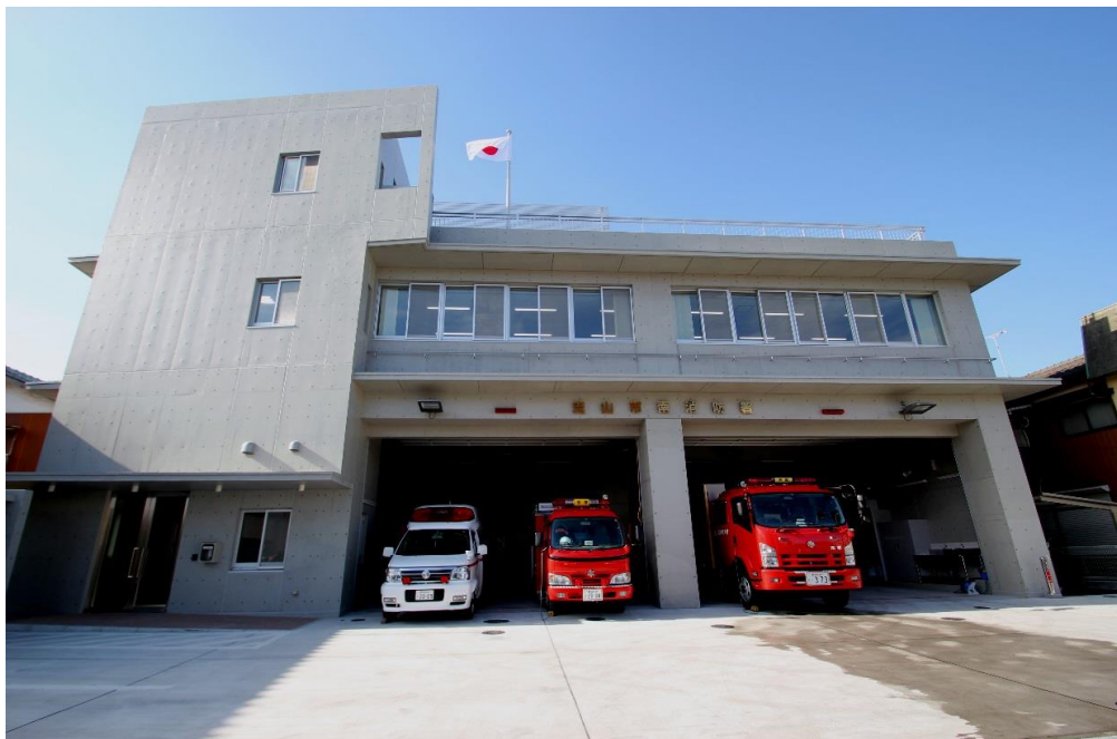
建設された南消防署新庁舎
