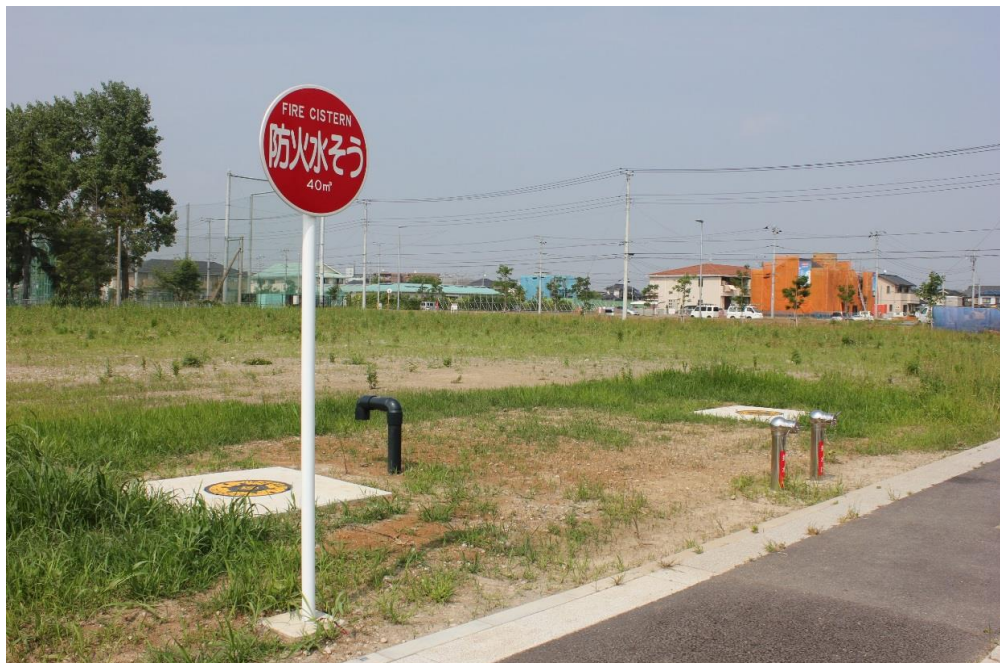
整備した防火水槽
