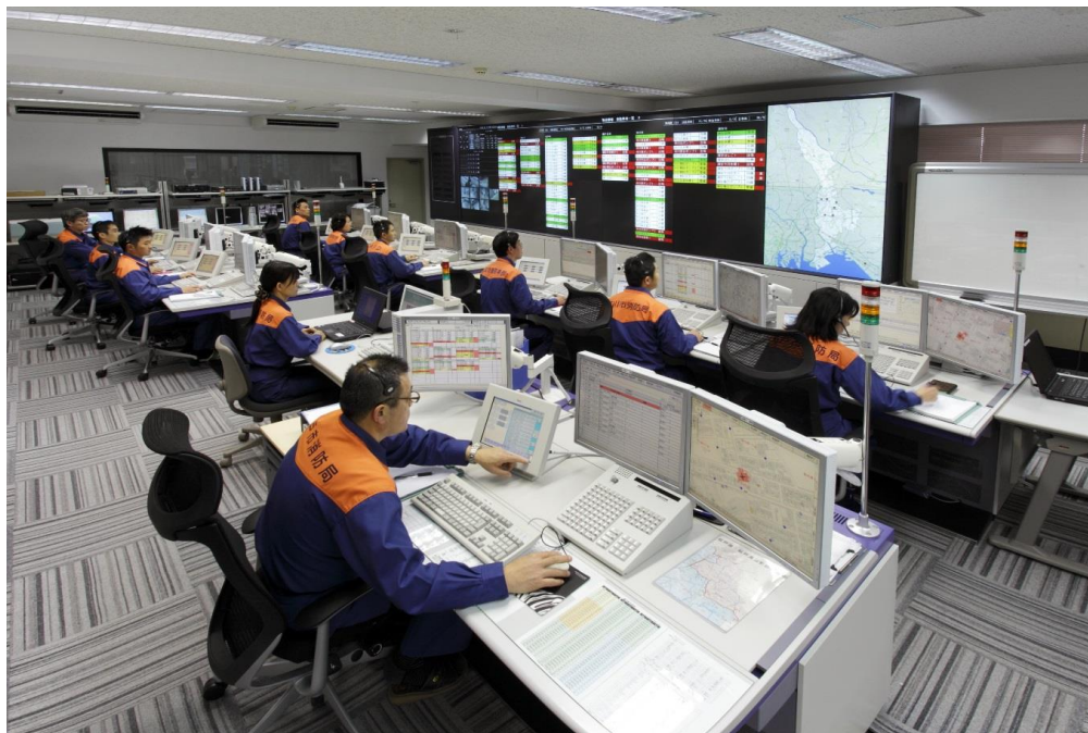
指令管制室の様子
