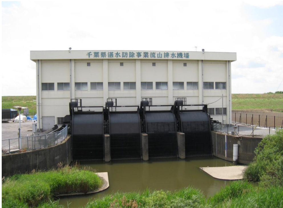
流山排水機場
