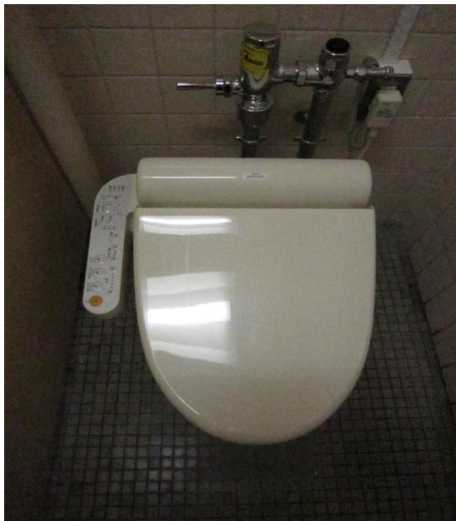
洗浄機付洋式トイレ改修工事
