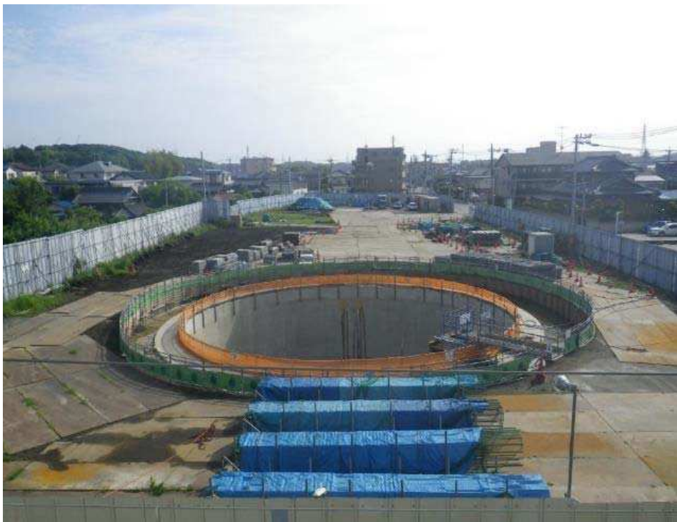
工事中の鯉ヶ崎調整池
