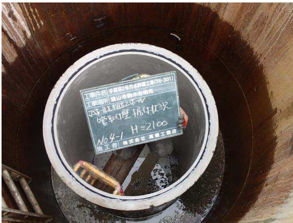
立坑内マンホール据付状況
