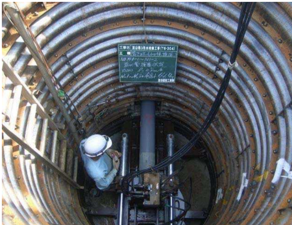
汚水官推進状況
