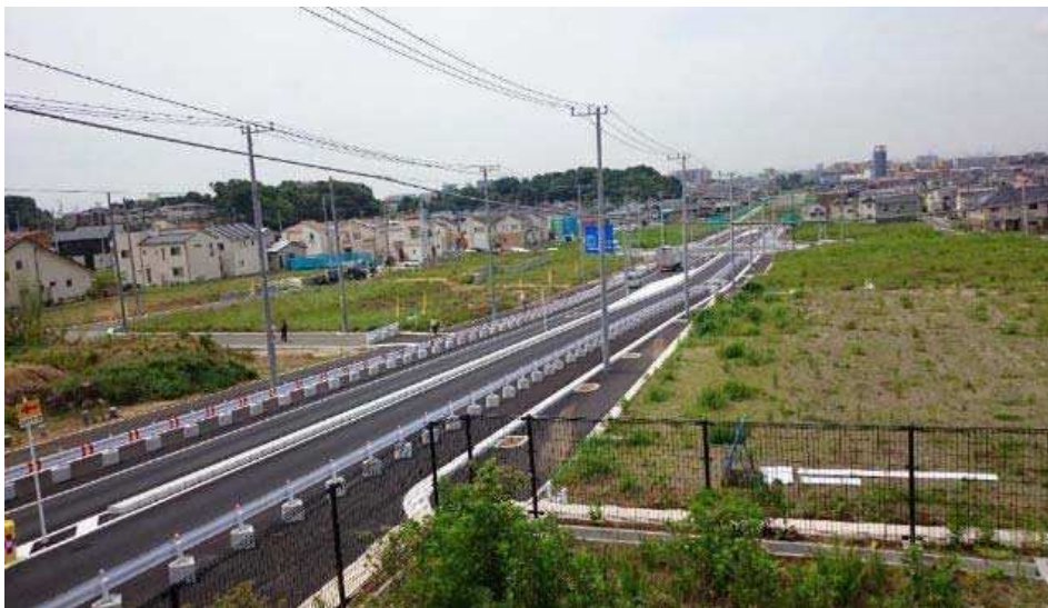
都市計画道路3・3・2号新川南流山線(本覚寺付近)
