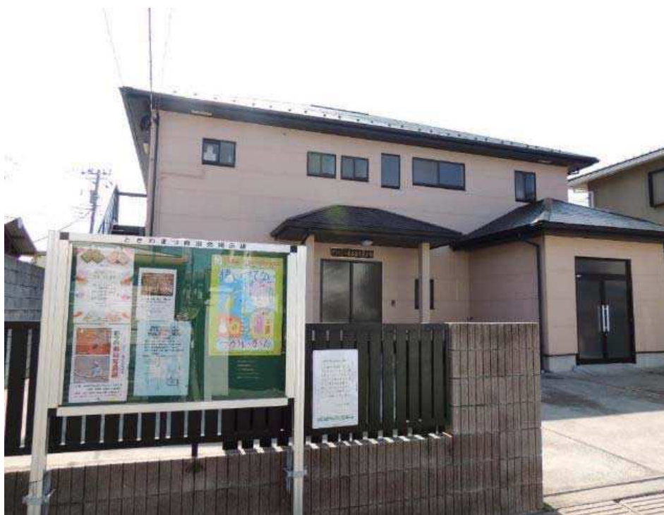
補助金を利用して改修工事を行った自治会館
