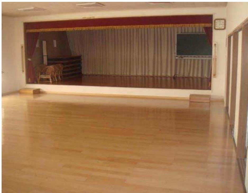
フローリングに改修した西深井福祉会館の大広間
