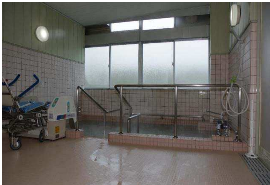
利用しやすくなった改修後の浴室
