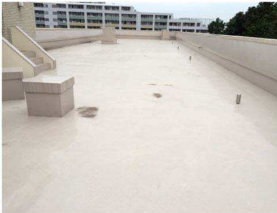
防水工事施工後の屋上
