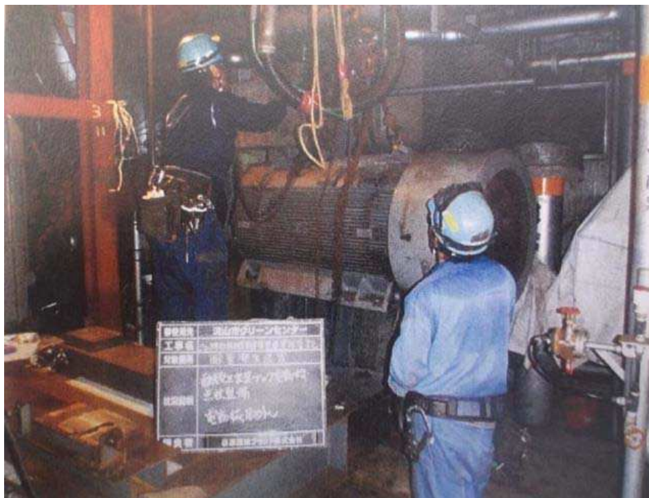
ごみ焼却施設定期年次点検の様子
