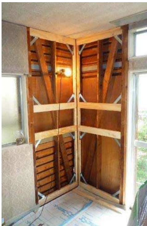
木造住宅に耐震補強を施工した状況
