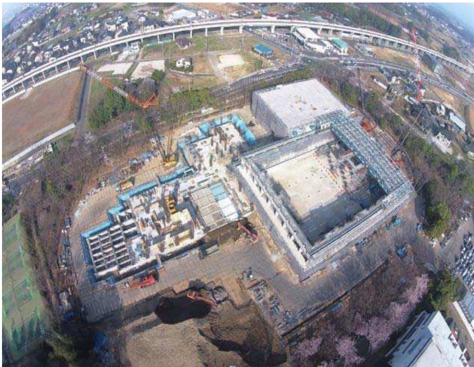
建設中の市民総合体育館
