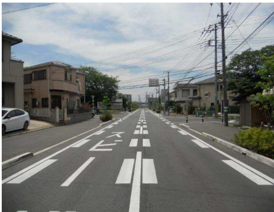
補修後の美田幹線道路
