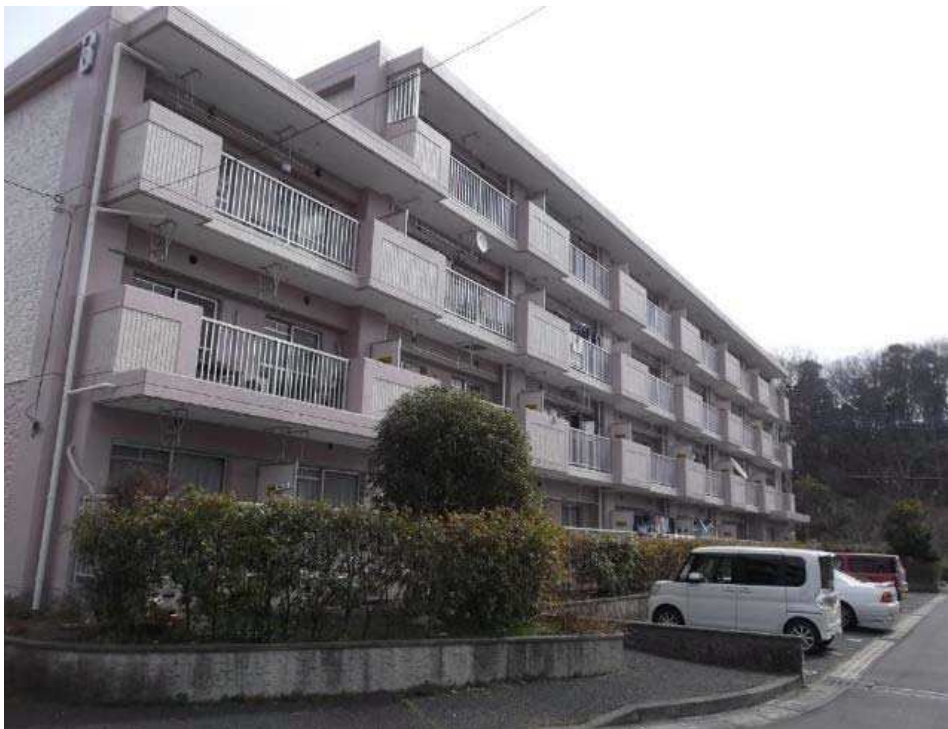
外壁改修工事完了後の市営住宅大橋団地3号棟
