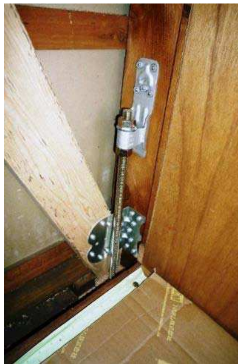
木造住宅に耐震補強を施工した状況
