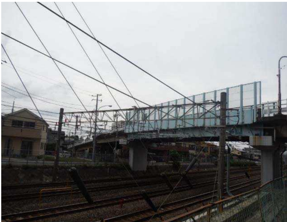
名都借跨線橋
