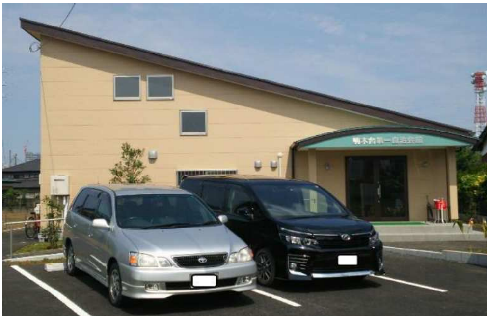
補助金を利用して建設を行った自治会館
