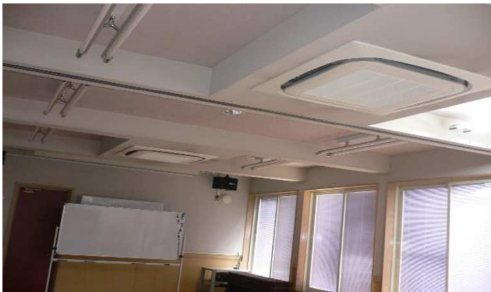
補助金を利用して改修工事を行った冷暖房機器
