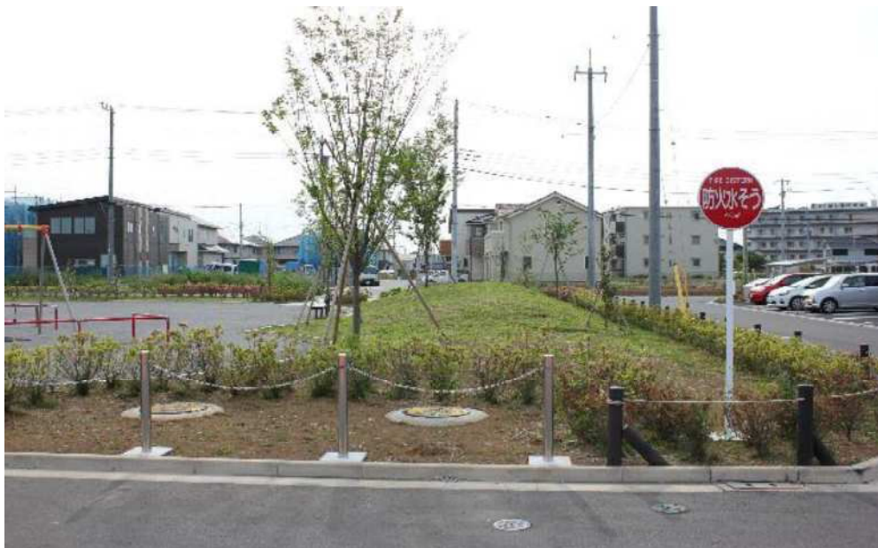
新たに整備した防火水槽（新市街地地区11号街区公園）
