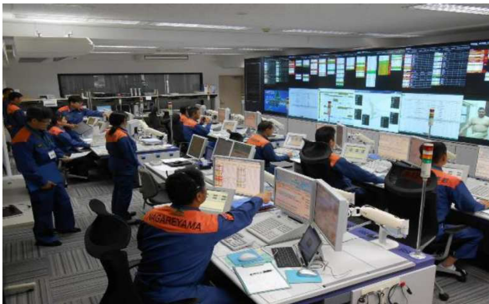
指令管制室内の様子
