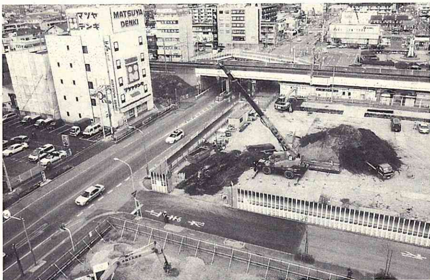
南流山駅周辺で進む常磐新線の建設工事
