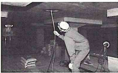
工事が行われている配水池の内部
