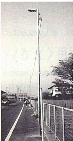
通学路に設置された防犯灯
