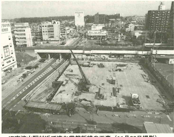
JR南流山駅付近で進む常磐新線の工事 (11月30日撮影)
