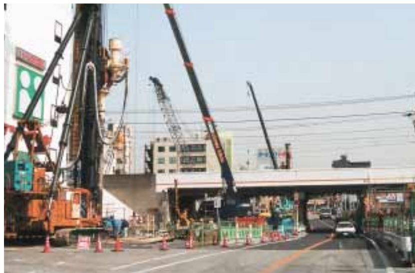
常磐新線の工事が進むJR南流山駅周辺
