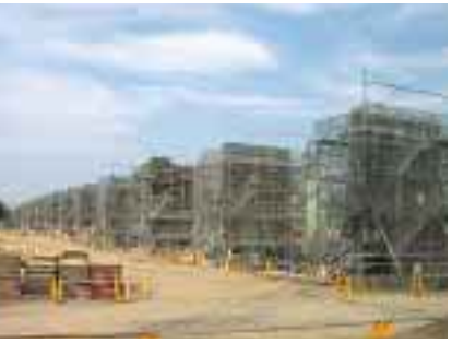
高架橋工事(駒木地区)
