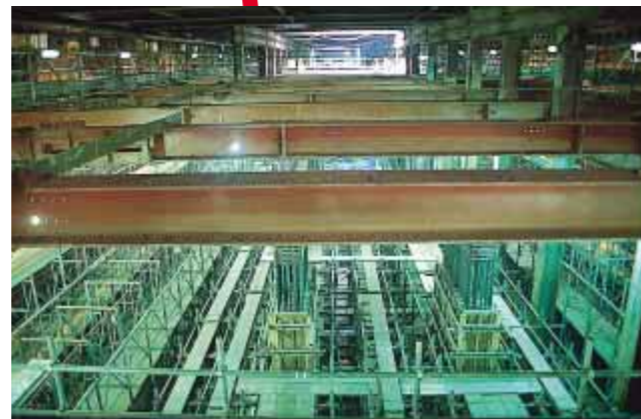
JR武蔵野線南流山駅前の地下では、新駅のく体工事が進んでいます。完成すると地下17m付近を電車が走ります。
