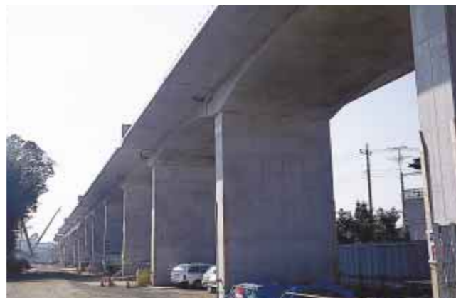
流山運動公園駅付近の高架橋は、シンプルで景観に配慮したアーチ形を採用。
