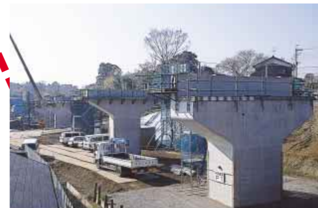
中地先でも高架橋の建設が着々と進んでいます。鉄道と交差する市道は、高架橋下をくぐる工事が行われます。
