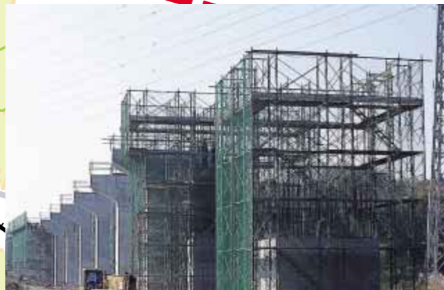
駒木地先の工事風景。つくばエクスプレスの高架橋に沿って、新しい都市軸道路の整備もやがてスタートします。
