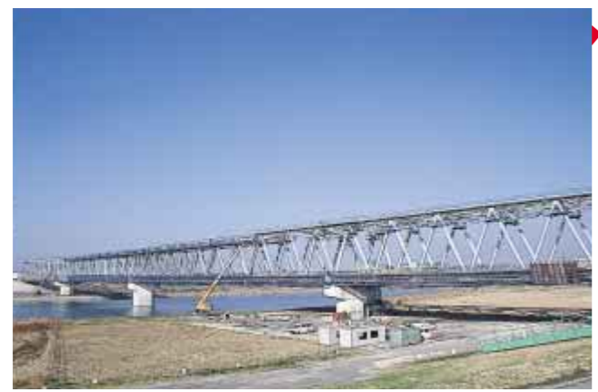
江戸川に架かる鉄橋は長さ418m。鋼材を三角形に組んだトラス形式で、平成14年8月埼玉側と1本につながりました。
