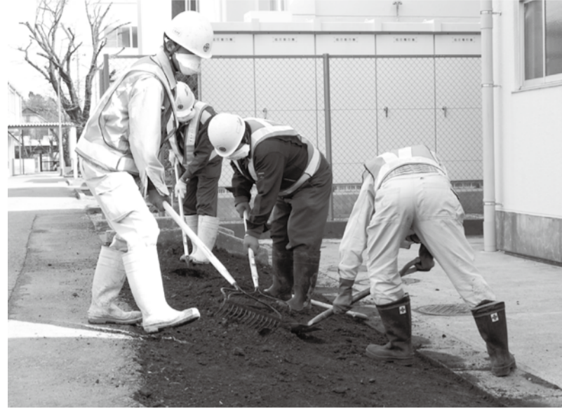
学校敷地内の土壌の表土除去
