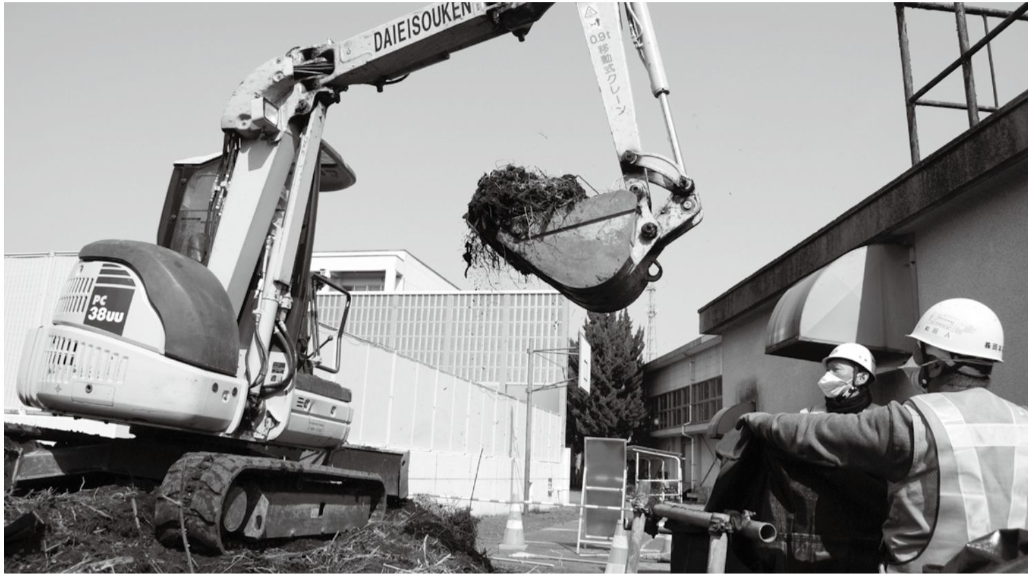
3月10日から約3週間かけて行われる八木中学校での除染作業。写真は、重機で敷地内の表土を削り取り、作業員が持つ袋に入れる様子(3月15日撮影)
