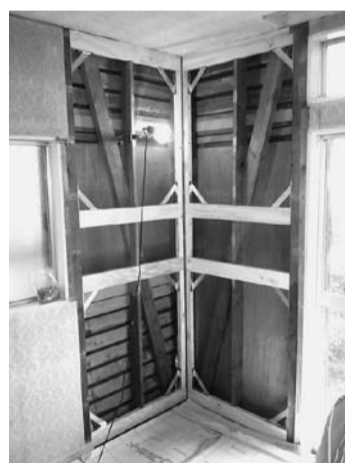
柱を新たに設置し筋かいを入れた耐力壁
