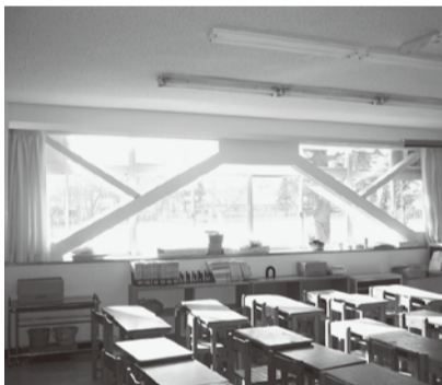
耐震改修の行われた教室
