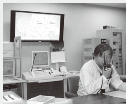
市役所内の防災行政無線室
