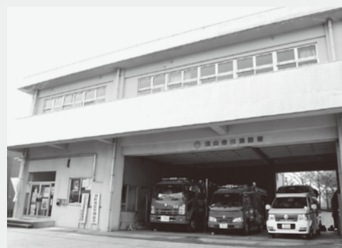
老朽化により建て替えられる南消防署
