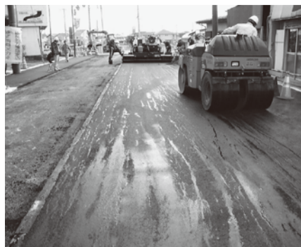
安全のための道路工事
