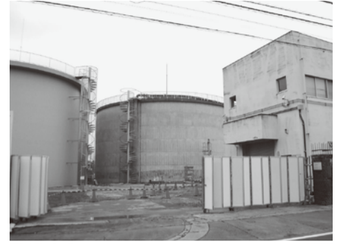
工事の進む江戸川台浄水場
