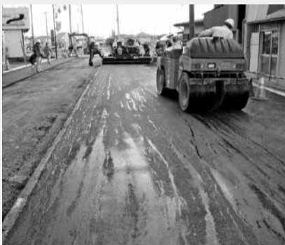
安全のための道路工事
