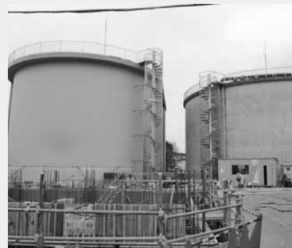
江戸川台浄水場の工事は今年度で完了
