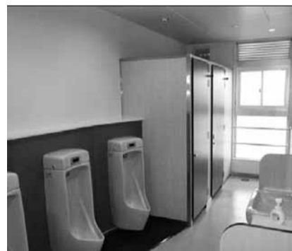
昨年度、改修工事が行われた南流山中のトイレ
