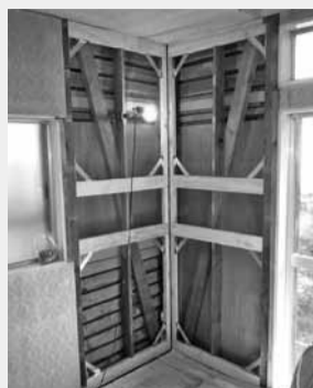
柱を新たに設置し筋交いを入れた耐力壁
