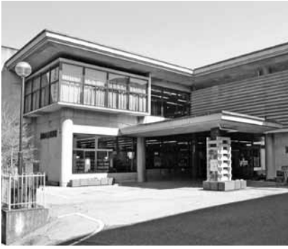
耐震工事などを行う中央図書館と博物館
