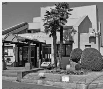
昨年度に改修した松ヶ丘自治会館
