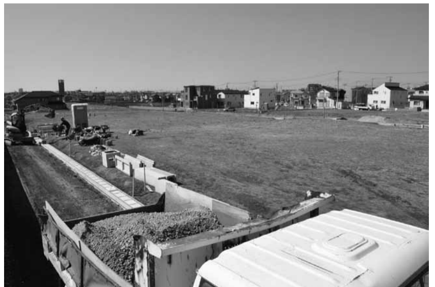
工事の進む西平井・鱒ヶ崎地区
