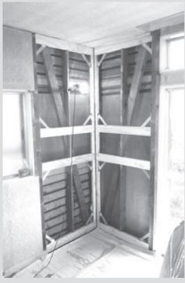
新たに柱と耐力壁を設置した改修例
