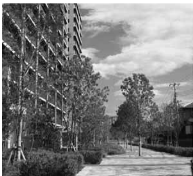
グリーンチェーン認定を受けたマンション
