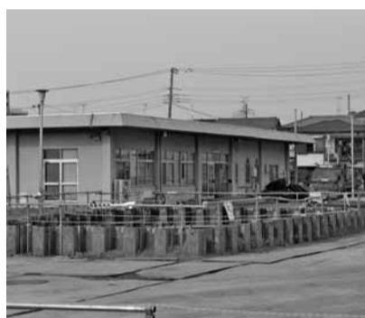
改修工事中の東部浄水場
