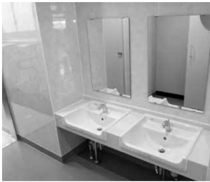
昨年度、改修工事が行われた南流山小のトイレ内
