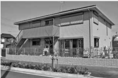
木地区にオープンしたグループホーム
