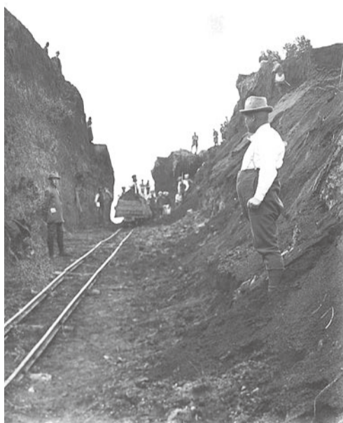
写真1 鱒ヶ崎切通し工事(大正4年ころ、呉服 婦人服新川屋蔵)
