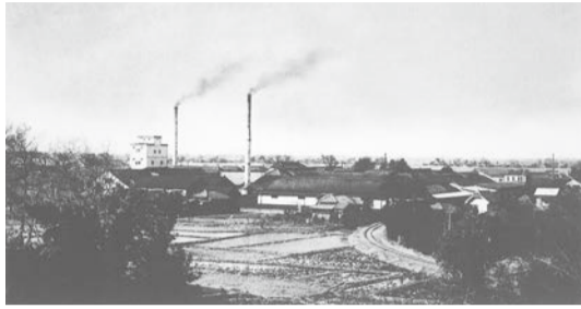
写真3 裏山(現在の市役所南側辺り)から見た野田醤油株式会社流山工場。カーブしている線路は工場への引き込み線(昭和15年ころ、キッコーマン国際食文化研究センター蔵)
